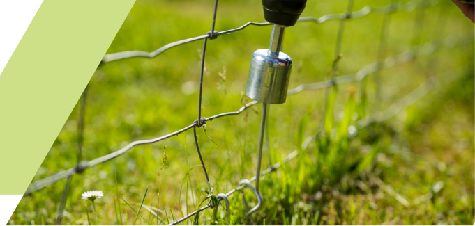
Vedação de autoestrada com o Fencing Pin Kit
